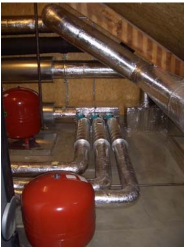
Gasbrennwertkessel, Leistung 15 – 60 KW pro Gebäude
