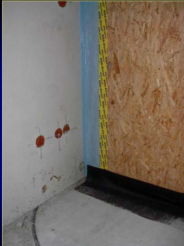
Anschluss Holzbau – Rohbau
