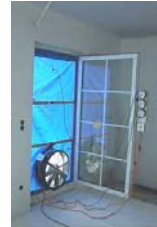
Blower-Door im Einsatz
