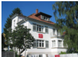
Wohngebäude Tuttlingen Baujahr 1932
