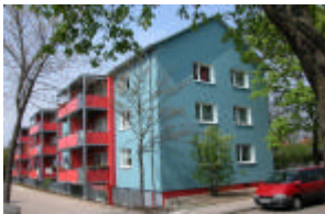
Mehrfamilienhaus Freiburg Baujahr 1961
